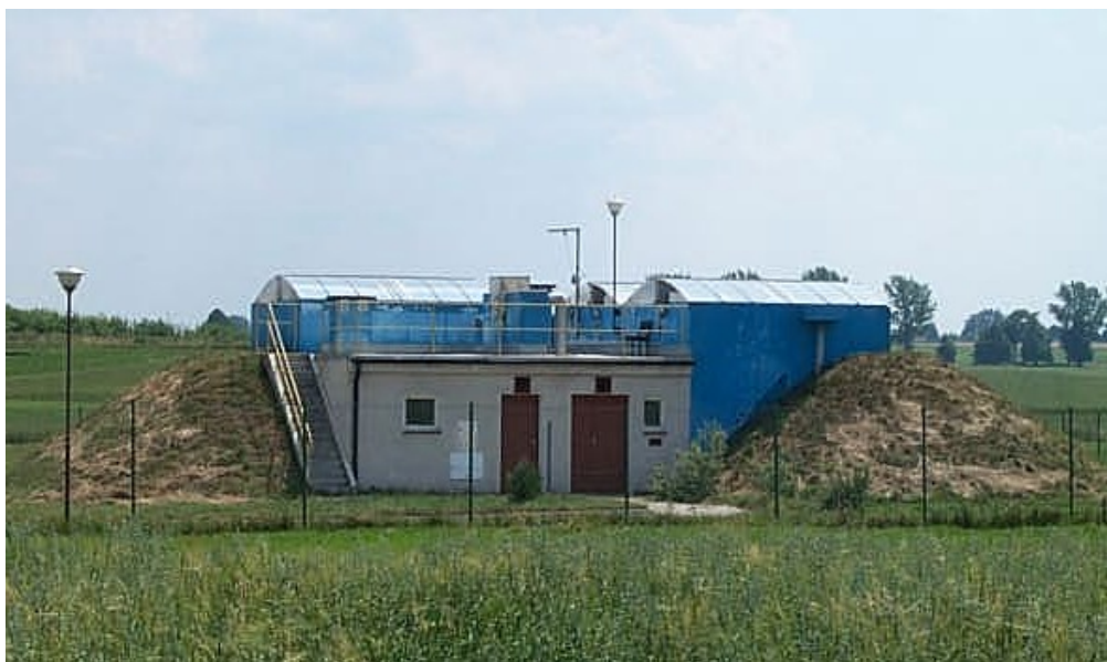
Zdjęcie 5. Oczyszczalnia ścieków w miejscowości Wąsewo
