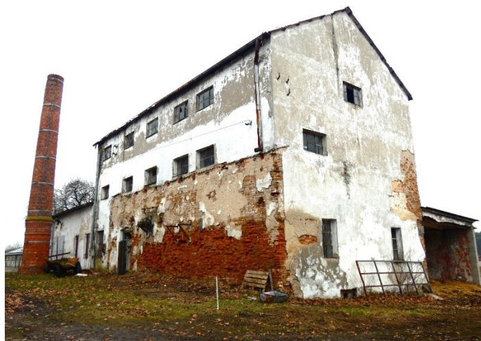
Fot. 13. Gorzelnia w Trynosach-Osiedlu
