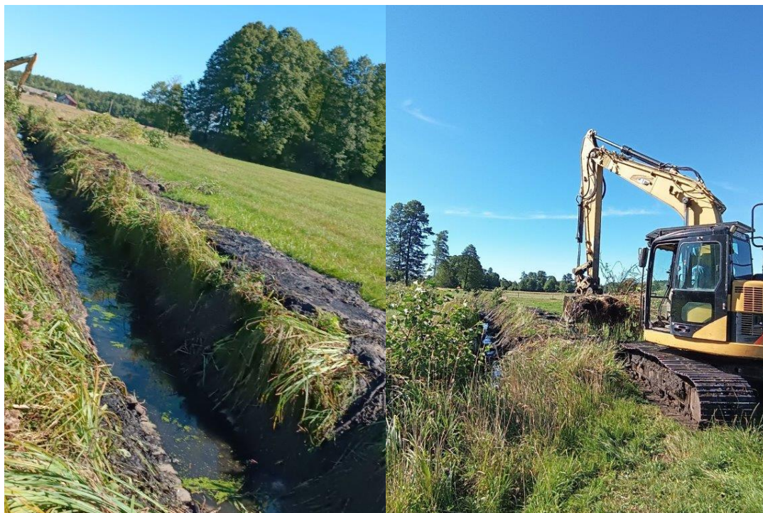
Zdjęcia przedstawiające usuwanie roślinności na rowach melioracji szczegółowej
