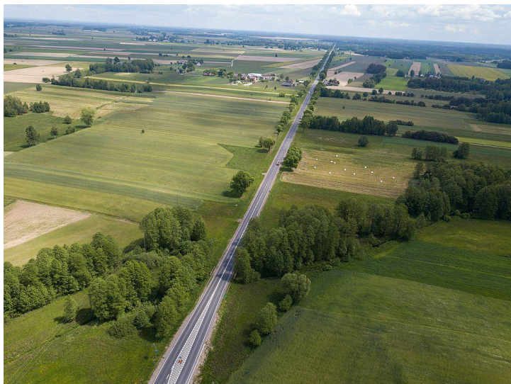
Widok na drogę krajową DK 60 w miejscowości Zastawie
