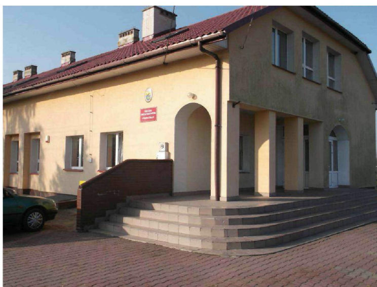
Budynek Publicznej Szkoły Podstawowej w Brudkach Starych
